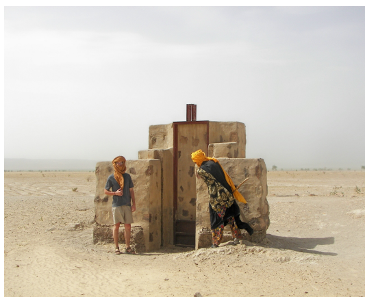
Ensablement intense entraînant la non fonctionnalité des infrastructures hydroagricoles, Tamashkoït Mai 2008
